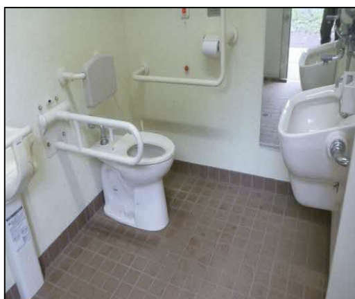
多目的トイレの設置
